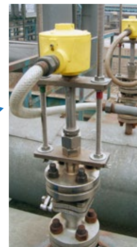
Instalación del ST110
